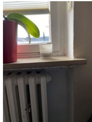
Heizkörper und Holzfenster
